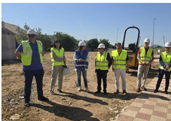
Comienzan las obras de canalización en Cobisa para acabar con las inundaciones
