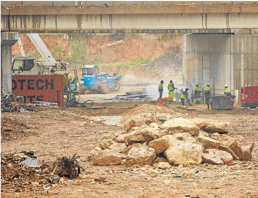
Trabajos de la CHJ sobre el barranco del Poyo. IVÁN ARLANDIS
